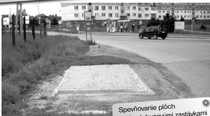
Spevňovanie plôch pod autobusovými zastávkami na Štefánikovej ul.
