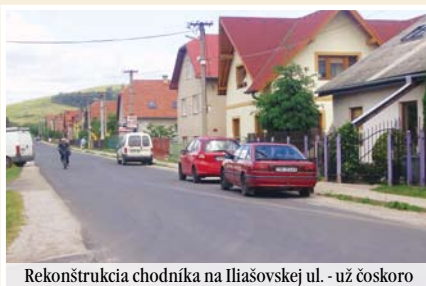
Rekonštrukcia chodníka na Iľiašovskej ul. - už čoskoro
