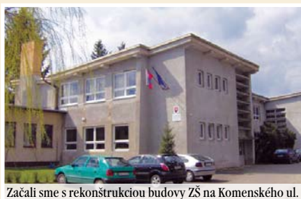
Začali sme s rekonštrukciou budovy ZŠ na Komenského ul.
